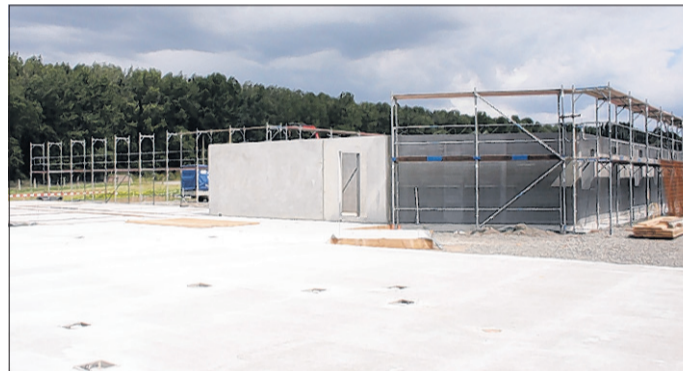
Einige Wände des Pflegezentrums stehen schon. Fotos: Ronny Schoof
